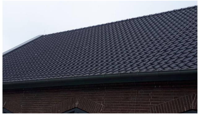
Abbildung 2: Nahaufnahme des Daches inkl. Blitzschutz
