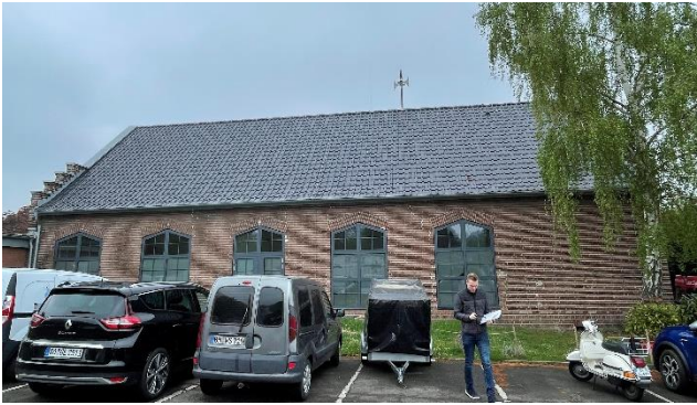
Abbildung 1: Südost Ansicht des Gebäudes
