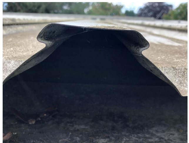
Abbildung 6: Nahaufnahme Blechdach (II, III, V)
