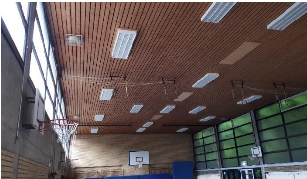
Abbildung 7: Innenansicht Flachdach IV
