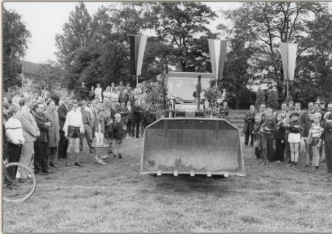
1. Spatenstich des Hallenbades Karlsbad mit der Planierraupe. Juni 1968
